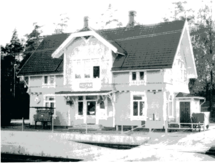
När Hestra socken till sist fick en egen poststation, förlades den till järnvägsstationen. (Foto i sept 1988 av Erik Lindgren)
