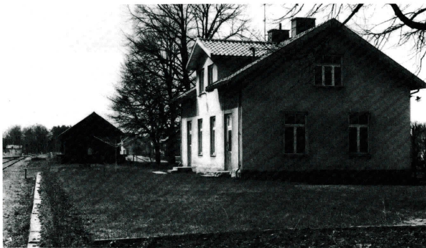
Posten i Traryd flyttades 1899 till järnvägsstationen. Denna är numera bostadshus och dess ursprungliga tegel har blivit övertäckt. Jämför byggnadsstilen med Markaryds västra station sid 29.
