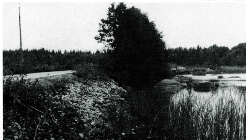
På gränsen mellan Allbo och Kinnevald lades en järnvägsbank över sjön Asnen. Sedan spåret rivits upp efter trafikens nedläggning år 1970 har cykelvägen "Asnen runt" lagts delvis på den gamla järnvägsbanken.
