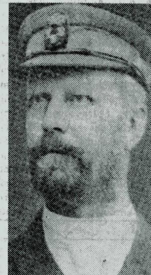
Greven Fredrik Posse lät olagligen bygga en järnväg - mitt i natten, när järnvägspersonalen sov. Då föddes banan mellan Rydsgård och Klagstorp.
